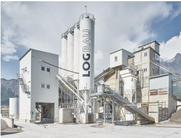
Mischanlage Werk Rheinau, Bad Ragaz
