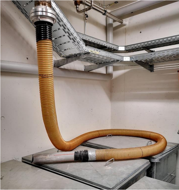
Abbildung 9 und Abbildung 10: festinstallierte Absaugleitungen für Holzaschen vor Ort (Bilder: Tobler Holz & Forst Consulting)
