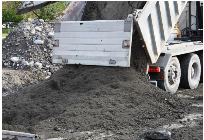
Auslieferung Ragazer Erdbeton im Kipper.
