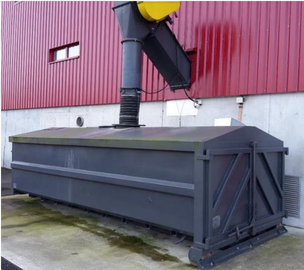
Abbildung 6: Beispiel der Austragung von Holzaschen in eine Mulde (Bild: Tobler Holz & Forst Consulting)
