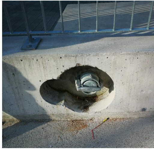
Abbildung 9 und Abbildung 10: festinstallierte Absaugleitungen für Holzaschen vor Ort (Bilder: Tobler Holz & Forst Consulting)
