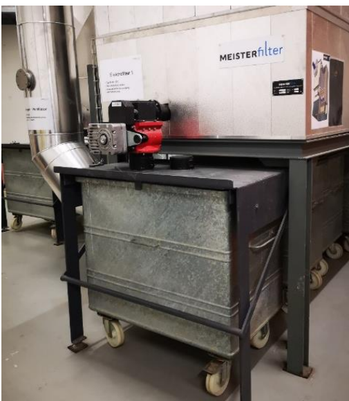
Abbildung 7: getrennte Zwischenlagerung von Flugaschen (Bild: Tobler Holz & Forst Consulting)
