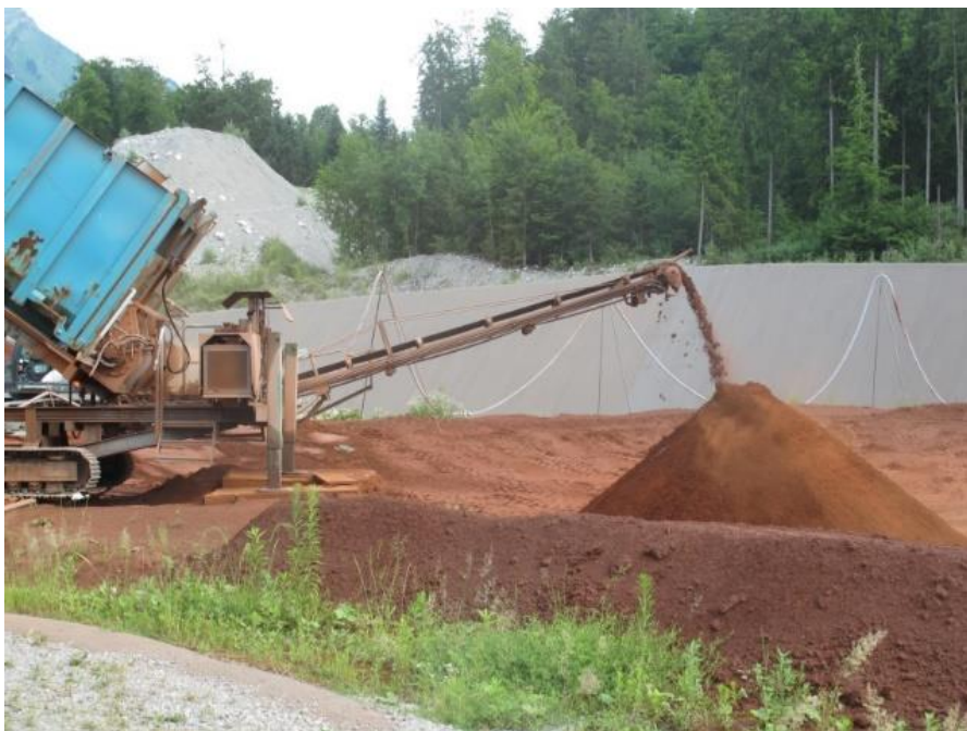
Abbildung 13: Staubfreier Transfer der im Container angelieferten und vor Ort befeuchteten Asche auf den Deponiekörper (Bild: A. Keel)
