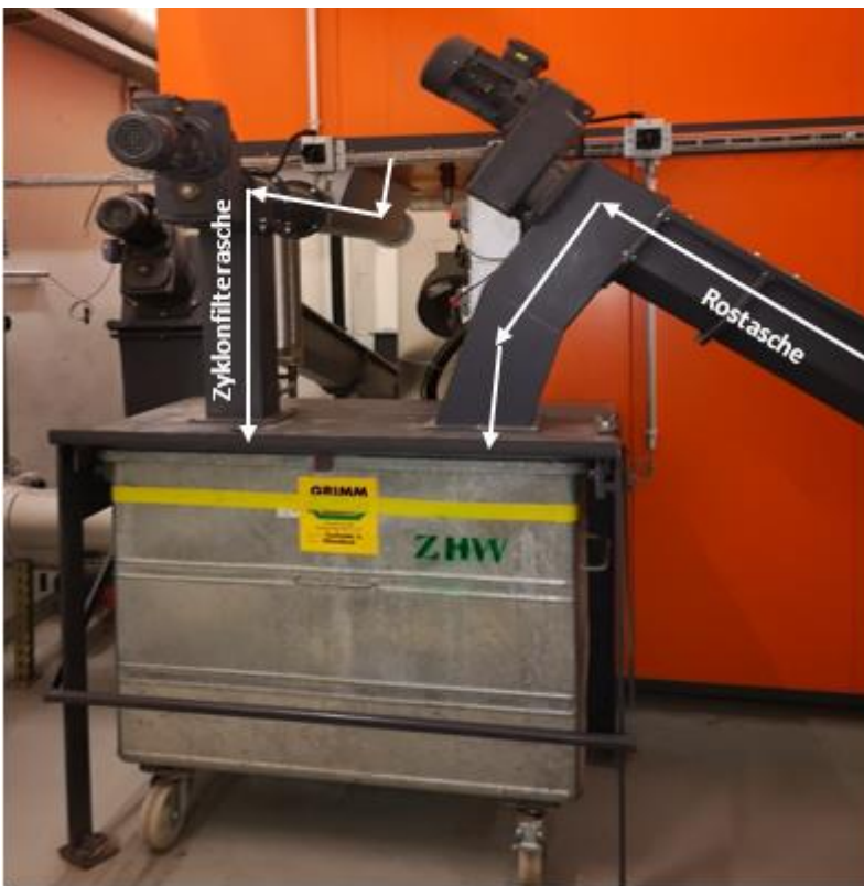
Abbildung 5: Beispiel der Austragung von Zyklonfilterasche in einen Container (Bild: Tobler Holz & Forst Consulting)
