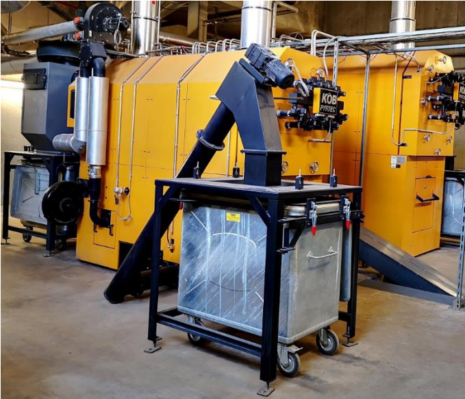
Abbildung 4: Beispiel der Austragung von Rostasche in einen Container (Bild: Tobler Holz & Forst Consulting)
