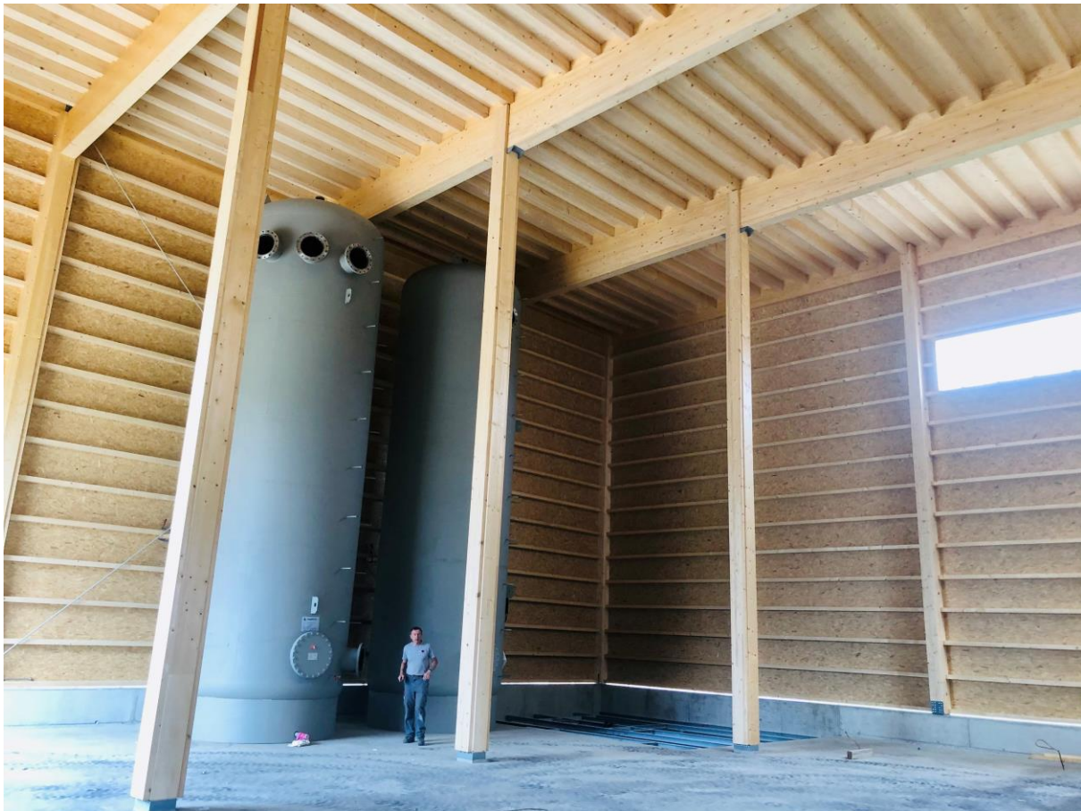
Wärmezentrale im Bau, aus einheimischem Holz in Lengnau BE
