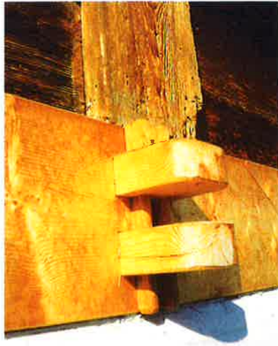
Auch neue Holzelemente wurden mit traditionellen Techniken fixiert.
