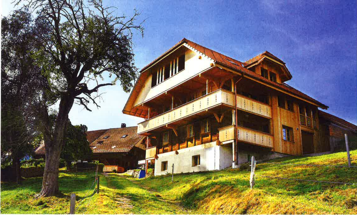
Das alte Wasch- und Ofenhaus der Familie Hebeisen in Fahrni erstrahlt in neuem Glanz und kann nun wieder bewohnt werden. Bei der Renovation wurde Konstruktionsholz aus der Region verwendet.
